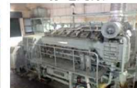
例：自家用発電機の整備
