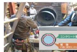
例：管路の耐震補強
